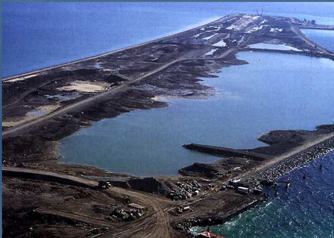
Peberholm - budowa sztucznej wyspy w cieśninie Sund (w trakcie prac)
