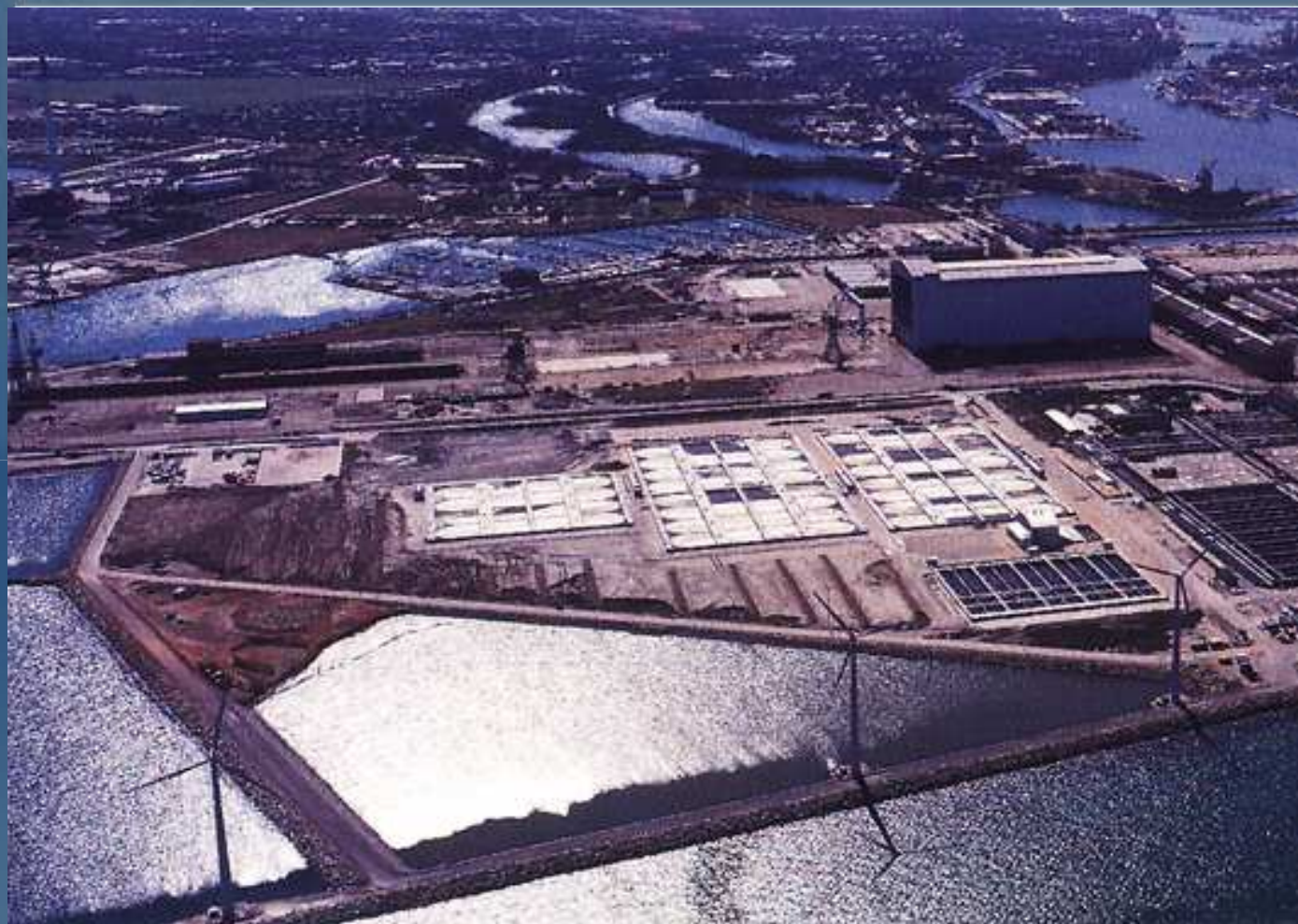
Kopenhaga - budowa oczyszczalni ścieków
