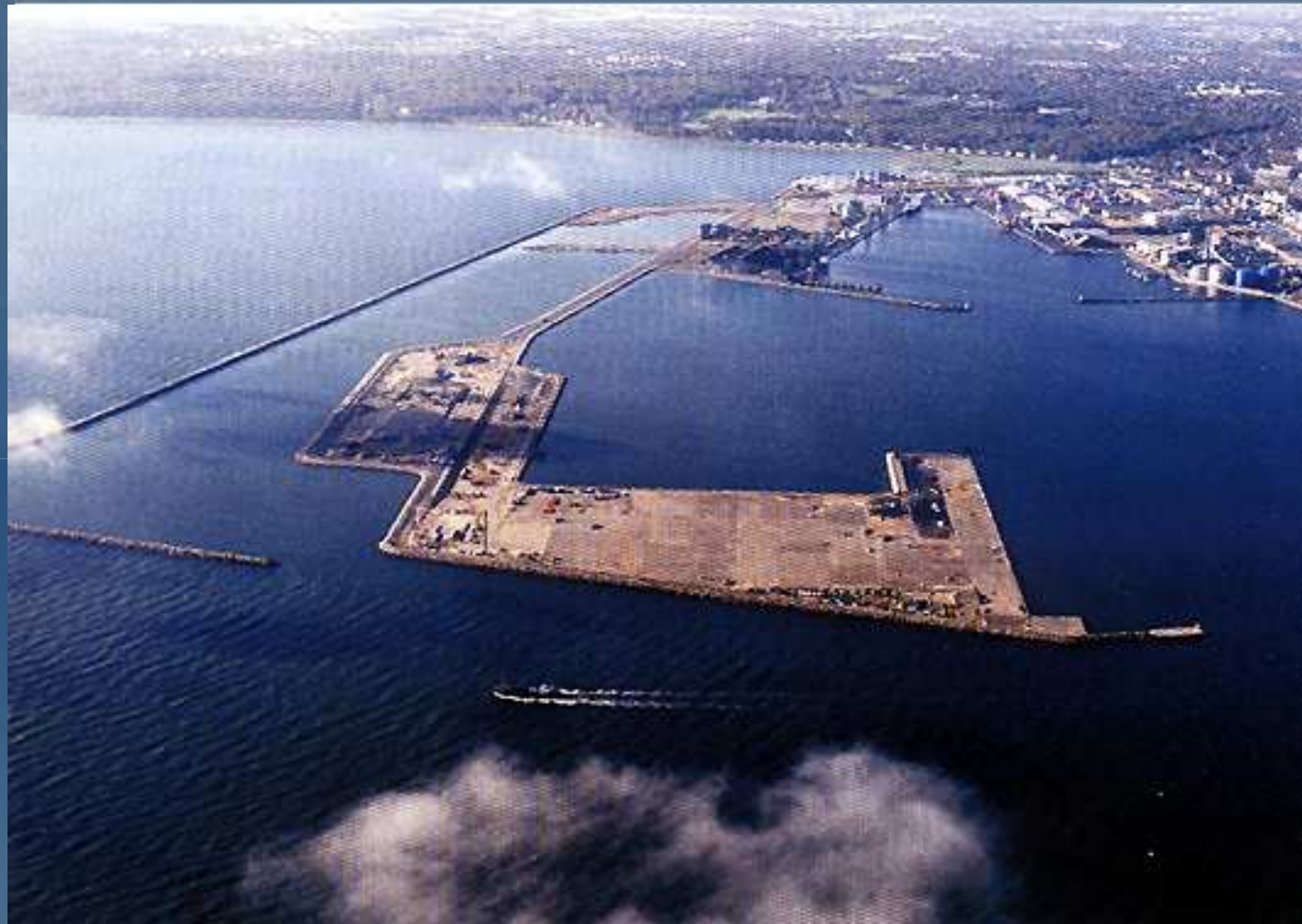
Aarhus - budowa portu
