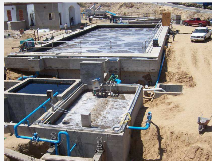
Exterior view WWTP Los Cabos
