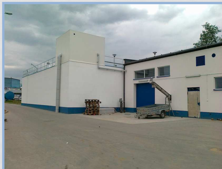
Betonowy zbiornik uśredniający – objętość ok. 620 m 3
